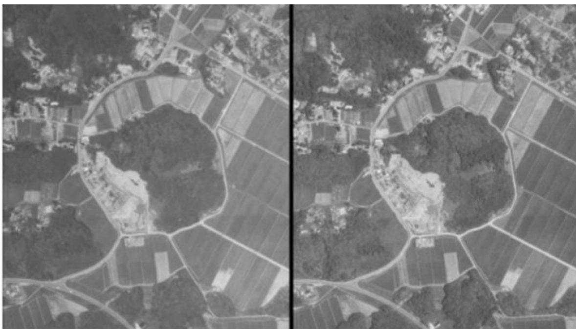
図2 切土進行中の西目地区
