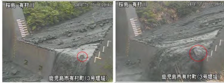
図3 再現性の良い土石流（左）と再現性の悪い土石流（右）
