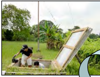
観測点整備の様子
