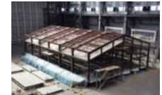
▲E-ディフェンスによる震動実験
