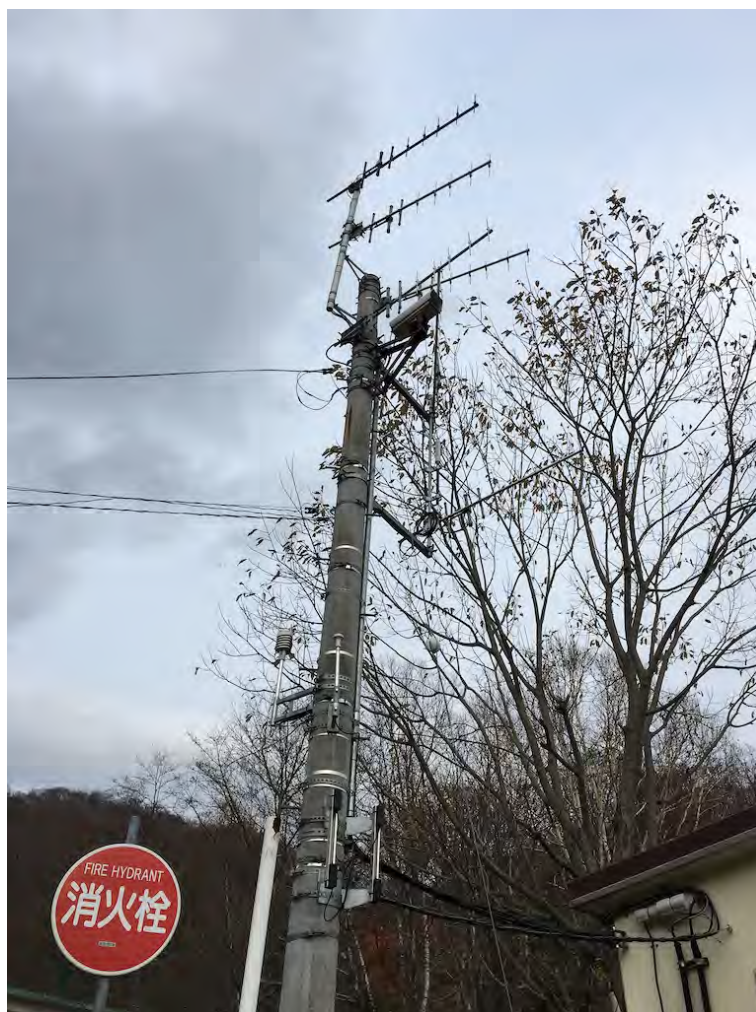
図 1. 樽前山の既設 400MHz 無線受信点の様子。この観測点に LoRa の試験のための受信機も設置した。
