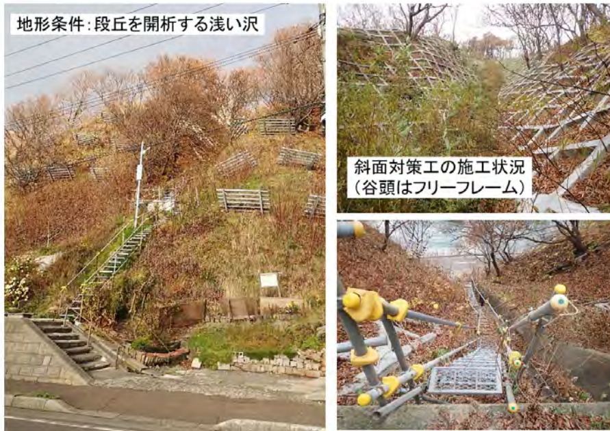
図3 避難設備の発災時における使用可能性の確認
