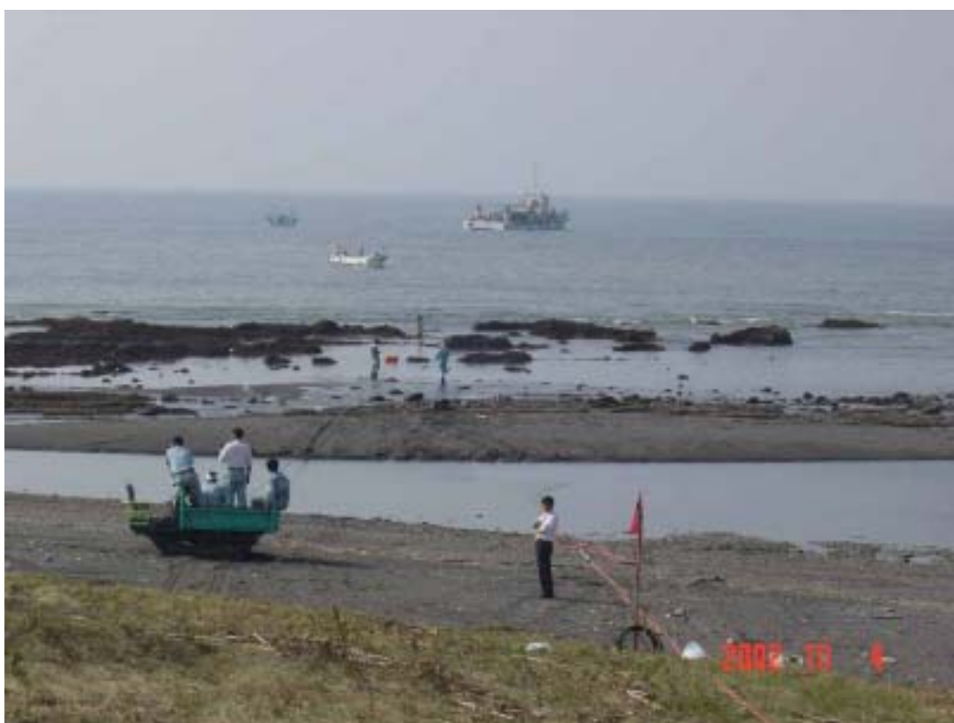
図9. 房総半島野島崎での海底ケーブルの敷設状況
