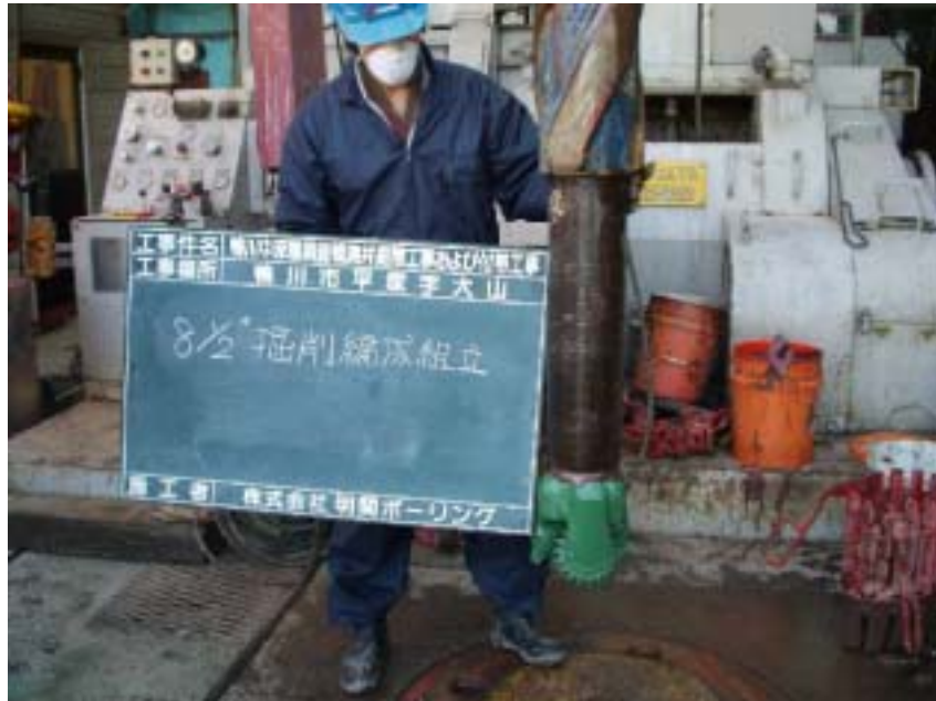
8-1/2 トリコン掘削作業写真
