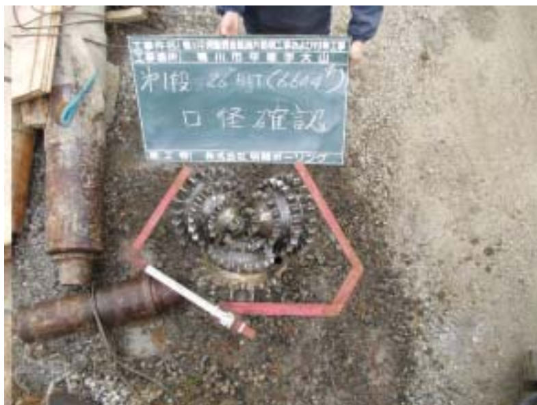
図 9 22 トリコン掘削作業写真
