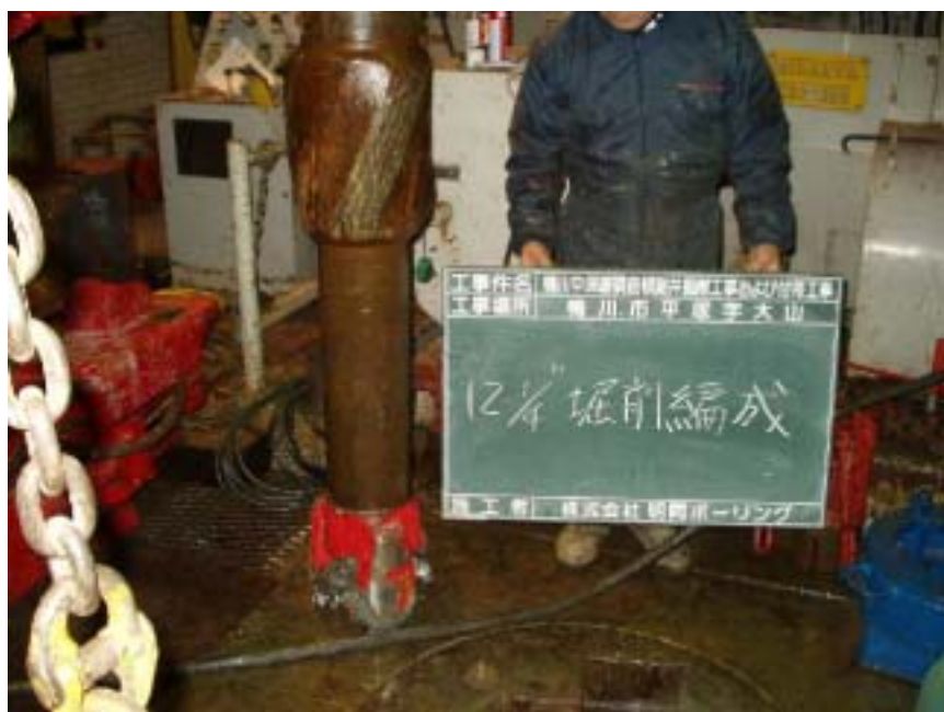
図 1 1 12-1/4 トリコン掘削作業写真
