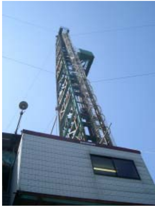
掘削装置全景 1
