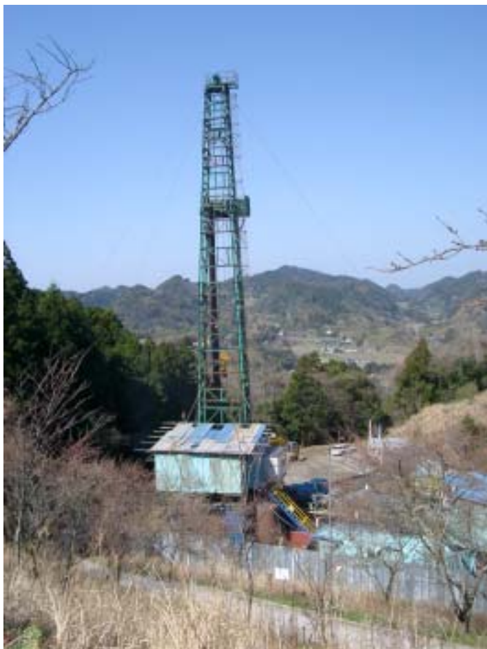
掘削装置全景 2
