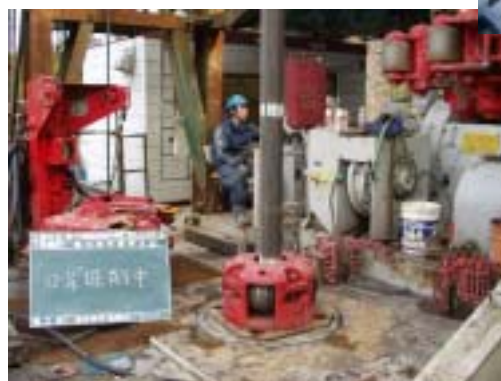
図1 2 8-1/2 トリコン掘削作業写真
