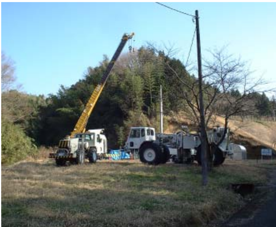
図16 垂直地震波探査作業風景
