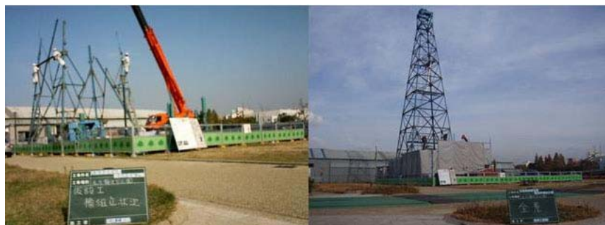
図9 櫓設営風景（左図：櫓の組み立て、右図：全景）
