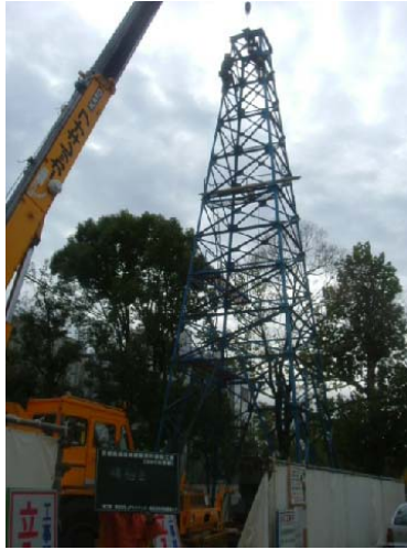
図 13 掘削槽の組み立て全景
