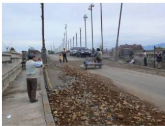
図-2.2 市内橋梁の被害
