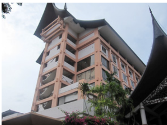
津波避難ビル候補の1つ（倒壊は免れたが、津波避難としての機能は有していない）
