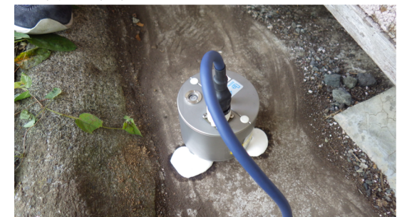
石膏で固定した地震計
