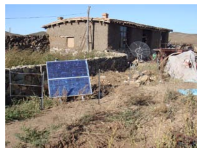
写真 3 設置後 (NE66) 矢印下に地震計とロガーが埋設されている
