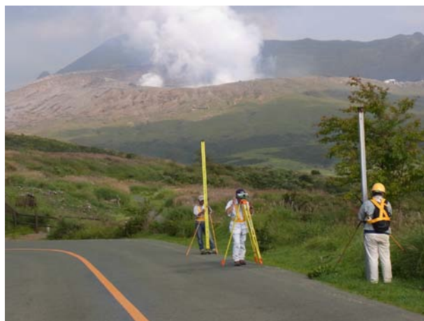
写真 1. 測量中の様子
