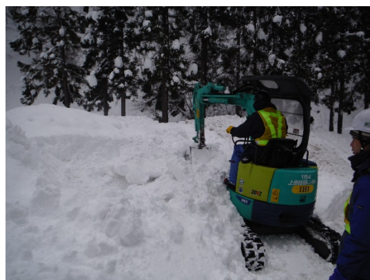
図 3、重機による GSX 回収風景
