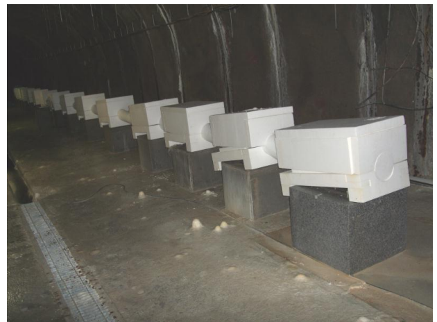
写真 1. 石英管伸縮計の被害状況 断熱用の発泡スチロールが全て台座から浮き上がっていた。
