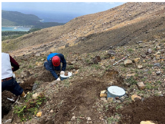
図 3. 新規観測点設置作業
