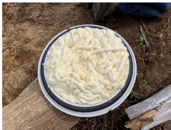
図 4. 発砲ウレタン塗布状況
