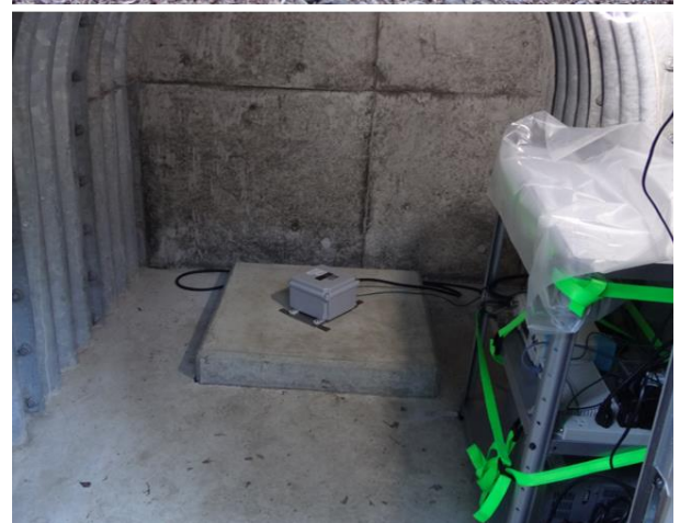
図 4：新尺里観測点の外観と観測壕内部
