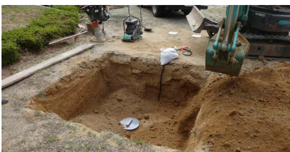
図 5. 地震計穴をバックホーで埋設・転圧
