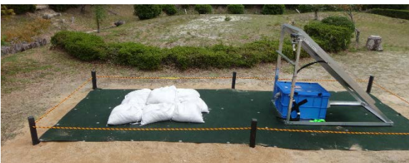
図 6. 防草シート・ソーラー架台・機器収納 BOX 等を設置
