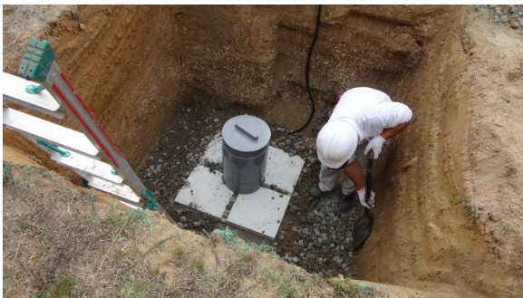
図 4. 地震計を設置しカバーを被せる
