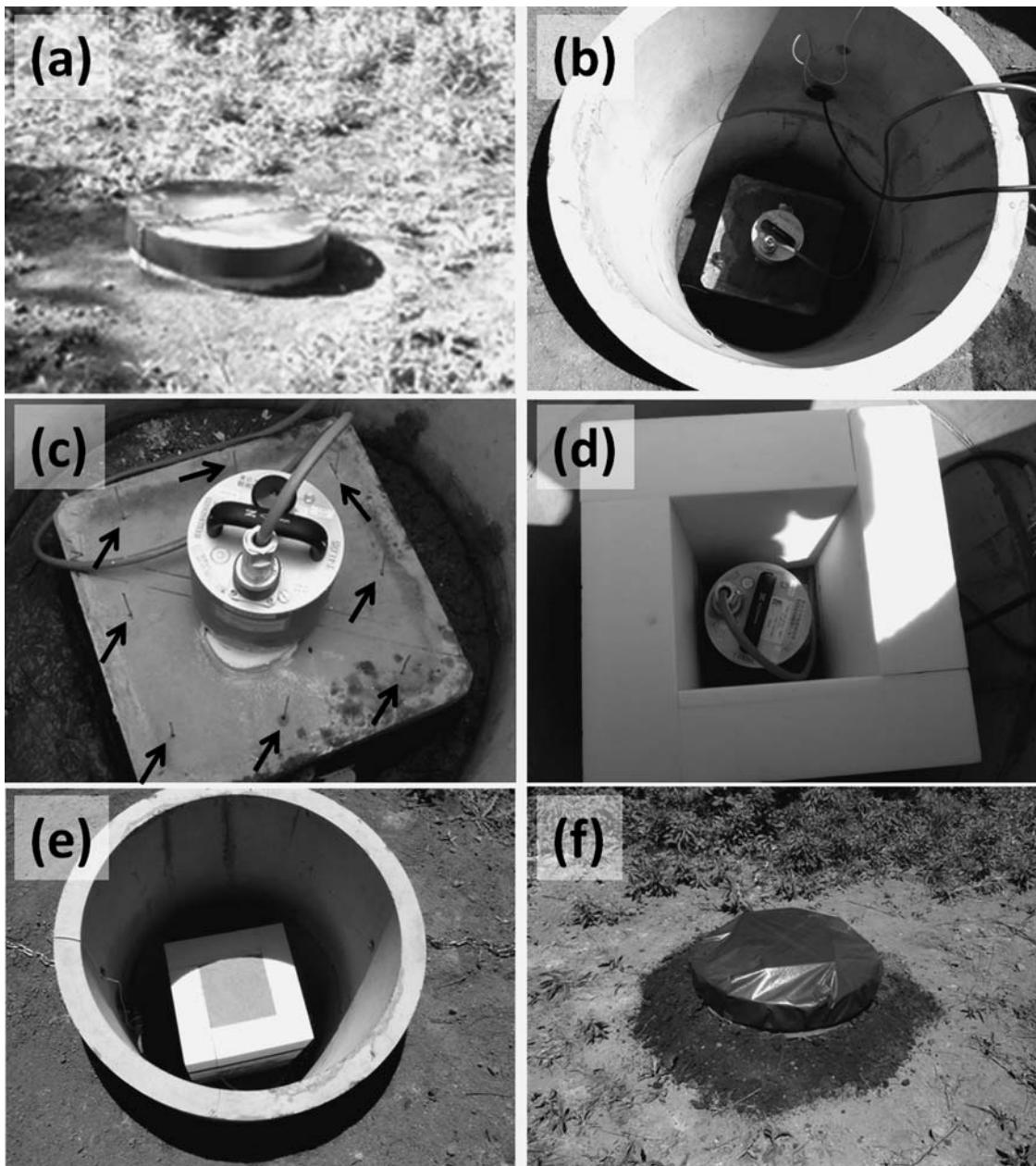
図 12. 茨城県に構築した新規広帯域地震観測点における、マンホール内への広帯域地震計設置の流れ。(a) 広帯域地震計を設置するマンホール(水戸東観測点; E. MTH)。地表部は鉄製カバーで蓋されている。(b) マンホール底部の地震計台に設置された広帯域地震計。強震動により地震計がずれないようにするために地震計の足の1つが石膏により地震計台に固定されている。(c) 地震計はスタイルフォームBOXで覆われるが、BOXが強震動によりずれないようするために、地震計台には8本の針金がアンカーされている(矢印)。スタイルフォームBOXは針金に刺し込むことによって地震計台に固定される。(d) 地震計をスタイルフォームBOXで覆う。(e) スタイルフォームBOX内は5号珪砂で充填される。その後スタイルフォームBOXの天板を乗せる。(f) 鉄製蓋を被せた後に、耐候性防水シートでマンホールを覆う。
