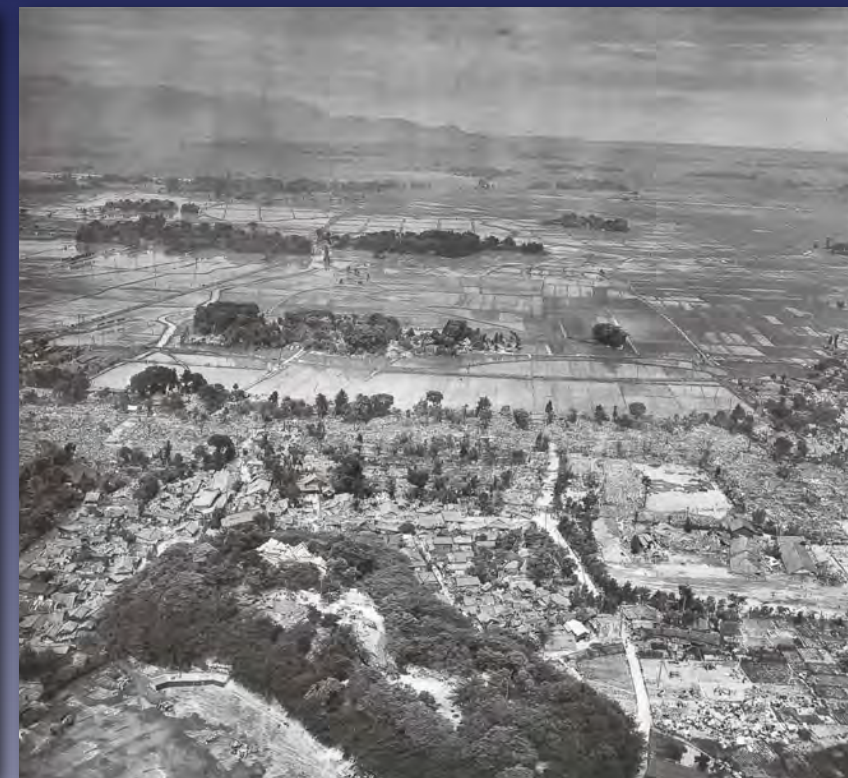
地震直後の丸岡城（現・坂井市） （いずれも中央防災会議報告書より抜粋）
