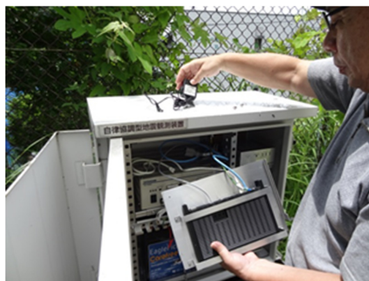
写真 1. 平戸小学校でのルータの電源コード交換実施の様子。
