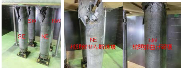
写真2 加力終了後の杭の破壊状況(杭頭部)
