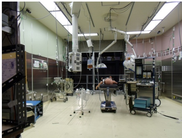
(a) 免震構造内の手術室
