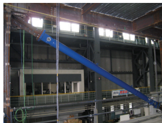
図 8 オイルの圧力を利用するダンパー
