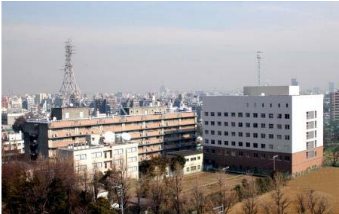
写真1: 地震研究所の新しい研究棟(写真右: 1号館). これまでの本館(写真左奥)は2号館, テレメータ棟(写真左手前)は3号館 と名称が変わった
