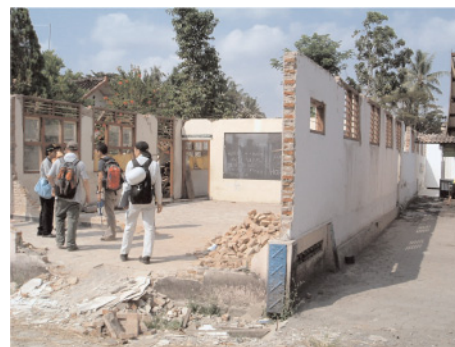
図4 : Kowen elementary school (図2②) 構造形式 : URM 建築年代 : 1975年 被害レベル : 大破
