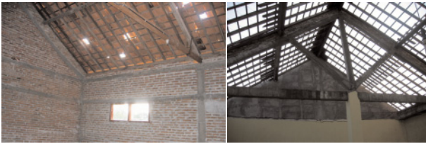
図 9：棧の上に瓦を載せただけの屋根
