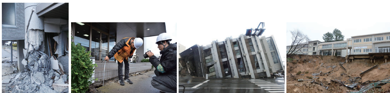
左から順に、写真1 せん断破壊した鉄筋コンクリート造柱、写真2 地盤沈下の程度の実測、写真3 転倒した鉄筋コンクリート造建物、写真4 崩落した地盤
